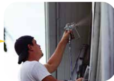
2. Apply primer (penetrating crystalline material)
